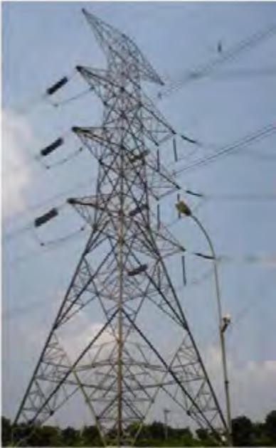
Gambar Isolator yang terpasang pada tension tower type DD
