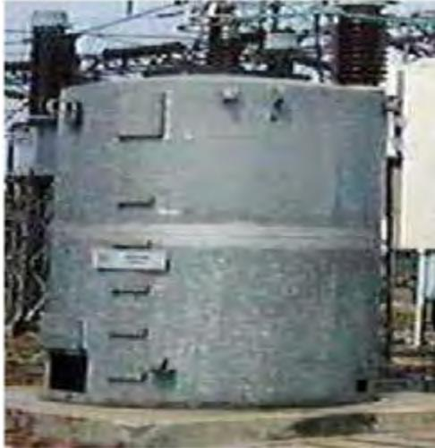
Gambar 5.8. Resistor Jenis Cairan (*liquid resistor*)
