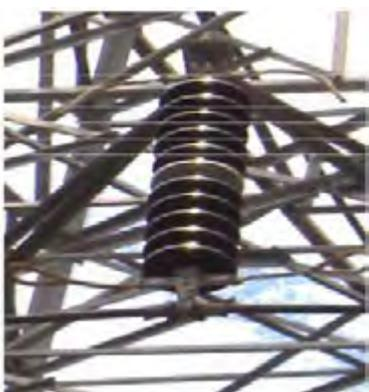
Gambar. Isolator renceng untuk tower suspension ("I" type)
