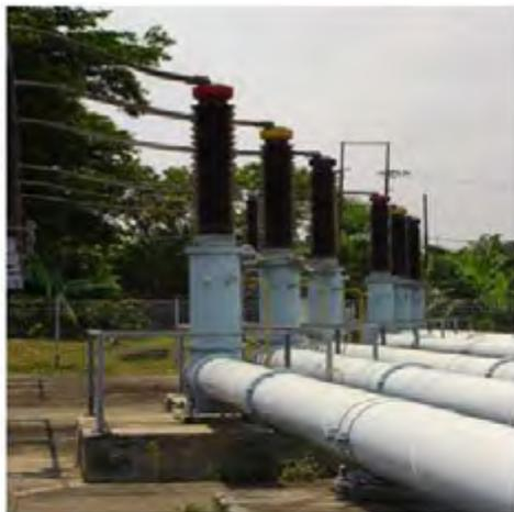
Gambar 4.5. Saluran Isolasi Gas
