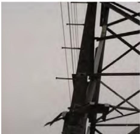
Gambar 4.19 Baut Panjat (step bolt)
