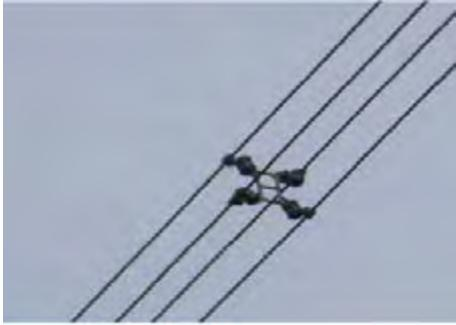
Gambar 4.34 Spacer untuk konduktor berkas 4 kawat (quadruple)
