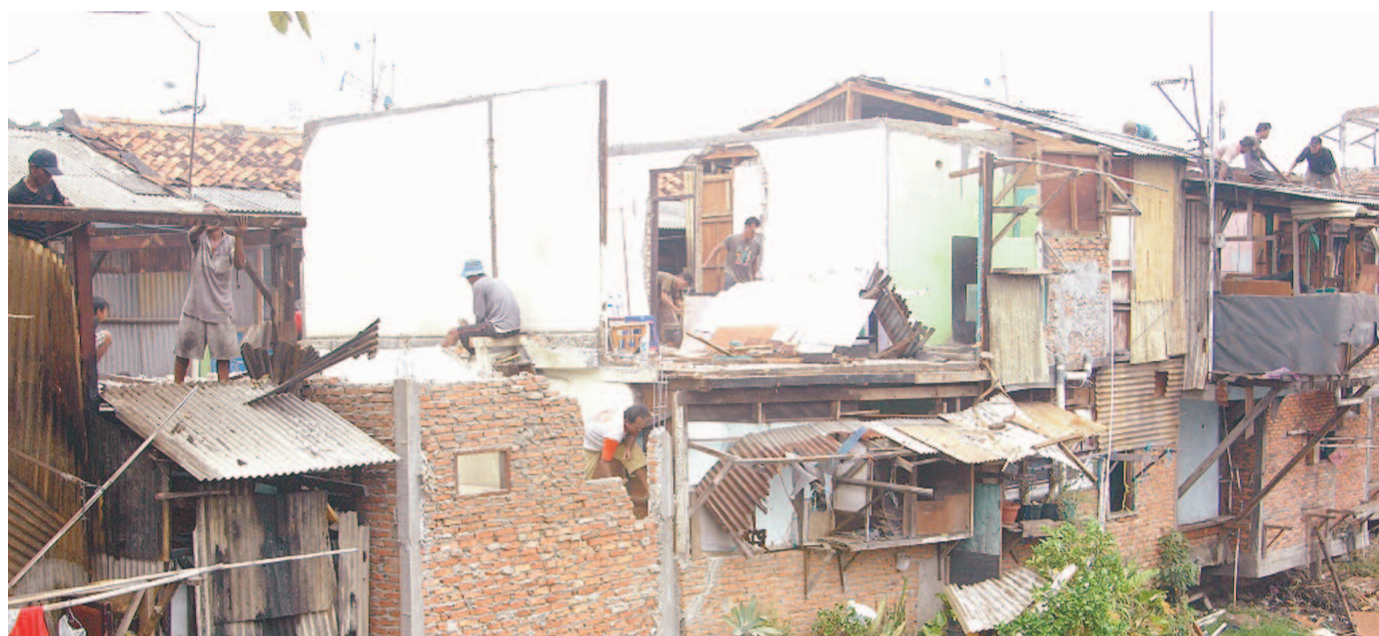
BONGKAR SENDIRI Sejumlah warga pemilik bangunan di bantaran Kali Duri, RT 007/010, Kelurahan Angke, Kecamatan Tambora, Jakarta Barat, Ahad (14/11), membongkar bangunan rumah yang akan dijadikan lokasi rumah pompa. Sebanyak 27 pemilik rumah mendapat kompensasi ditempatkan di rumah susun (rusun) bersubsidi di Marunda, Jakarta Utara.
