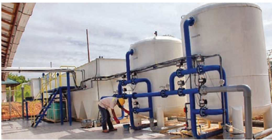
AIR BERSIH: Seorang pekerja sedang memeriksa tangki air bersih yang diperoleh dari hasil pengolahan air tambang.
