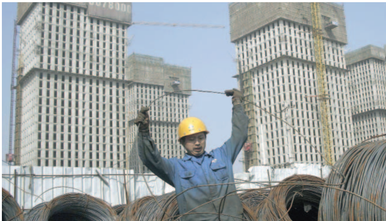
Seorang pekerja mengerjakan proyek pembangunan di Taiyuan, Provinsi Shanxi, Cina.
