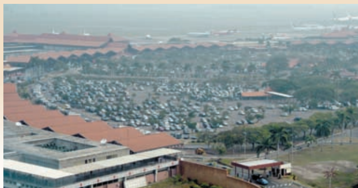
Terminal 1 di Bandara Soekarno-Hatta, Tangerang, Banten.
