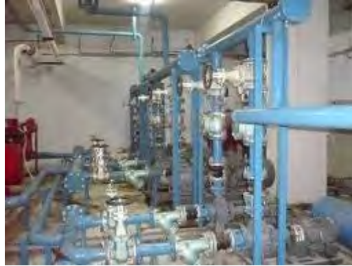
Gambar 3.1. Sistem pemipaan minyak
