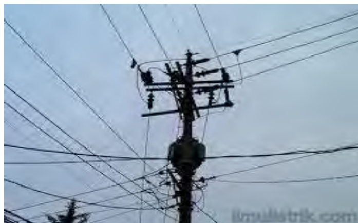
Gambar 4.25 Jaringan tegangan menengah
