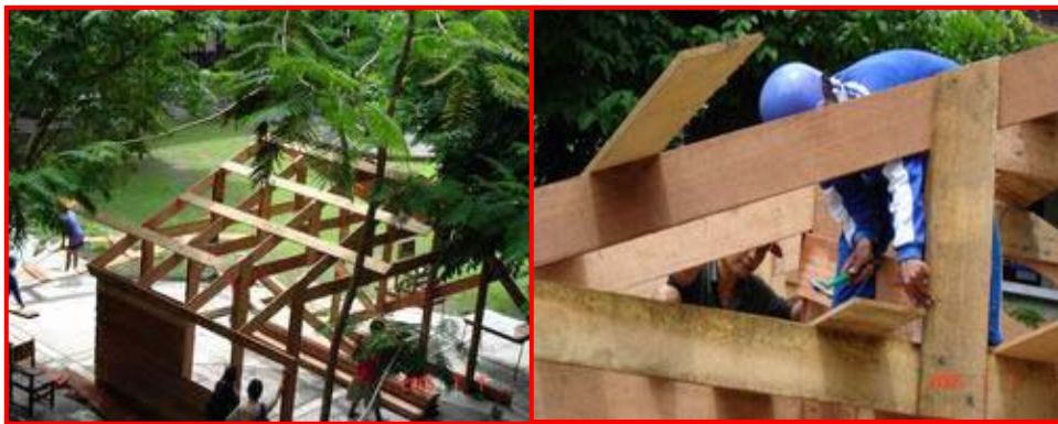
Gambar XI-25, Pemasangan Kuda-Kuda Sistem Knock Down
