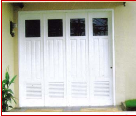
Gambar XIII-8, Hasil Pekerjaan Pengecatan Kayu pada Pintu Garasi
