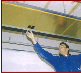
Gambar XII-16, Penutup Plafon dari Bahan Plat dengan Rangka Besi
