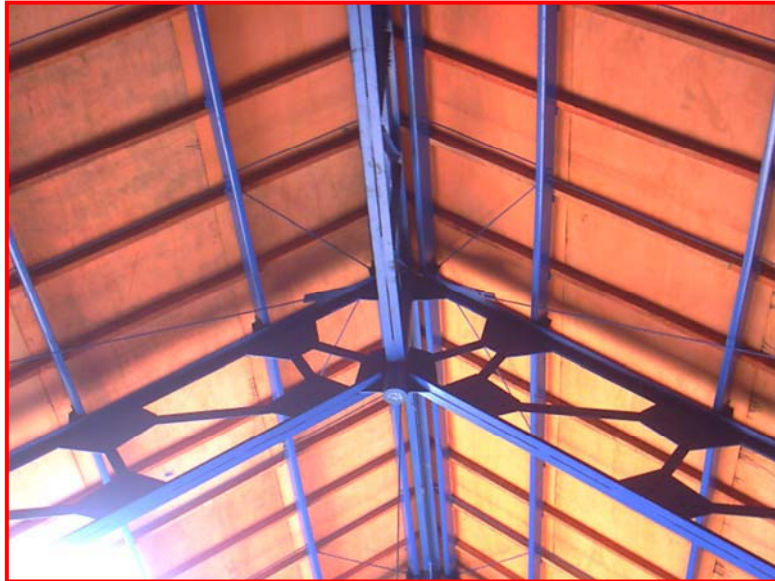
Gambar XI-42, Rangka Atap Baja
