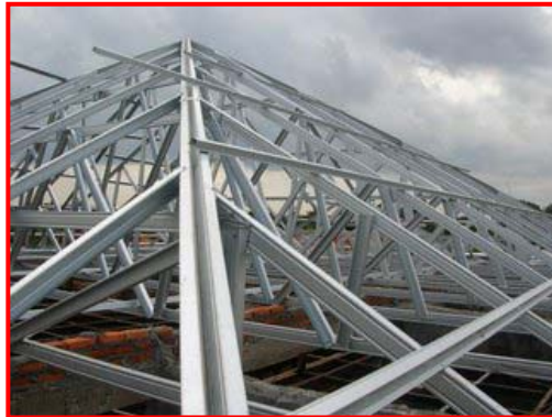
Gambar XI-43, Rangka Atap Baja Ringan (A)
