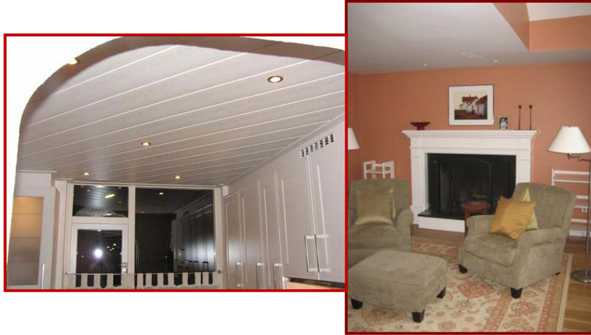
Gambar XIII-6, Hasil Pekerjaan Pengecatan Plafon
