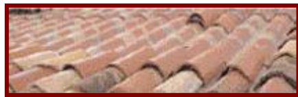
Gambar XI-37, Tampak Muka Pemasangan Genteng S
