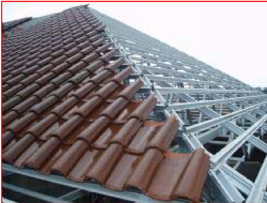
Gambar XI-44, Rangka Atap Baja Ringan (B)
