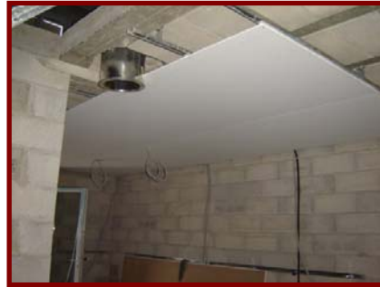
Gambar XII-16, Penutup Plafon dari Bahan Plat dengan Rangka Besi
