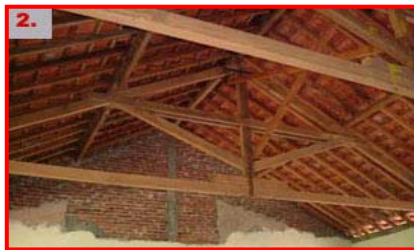
Gambar XI-22, Pemasangan Kuda-Kuda
