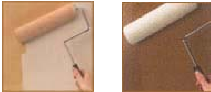
Gambar XIII-3, Pengecatan dengan Rol
