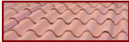
Gambar XI-37, Tampak Muka Pemasangan Genteng S
