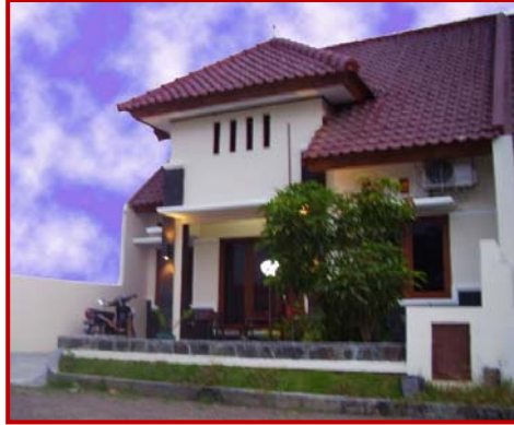
Gambar XIII-7, Hasil Pekerjaan pengecatan Genteng
