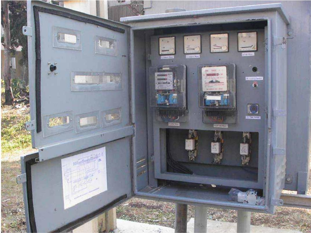
Gambar 2.16 Kwh meter tiga fasa dan KVARh
